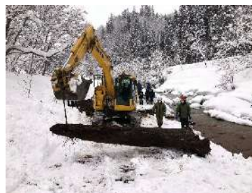
W6の引き上げ
